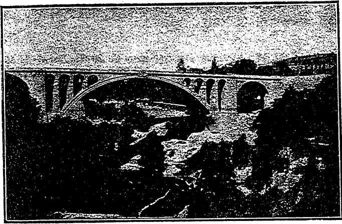
Fig. 14.—Vista general del puente de Luxemburgo.
