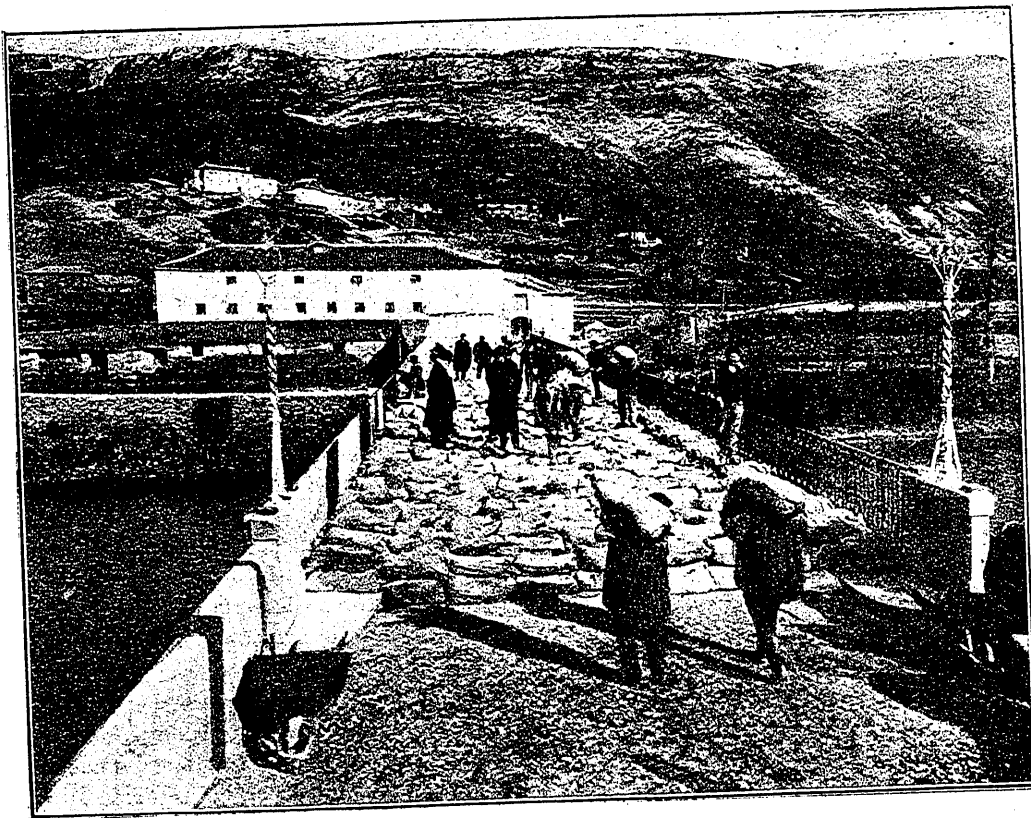
Puente de Liédena sobre el Irati.—Pruebas estáticas.
