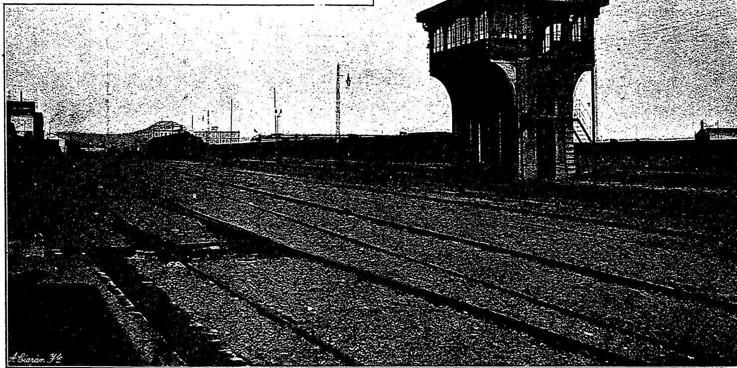
Puesto de enclavamientos núm. 2.
