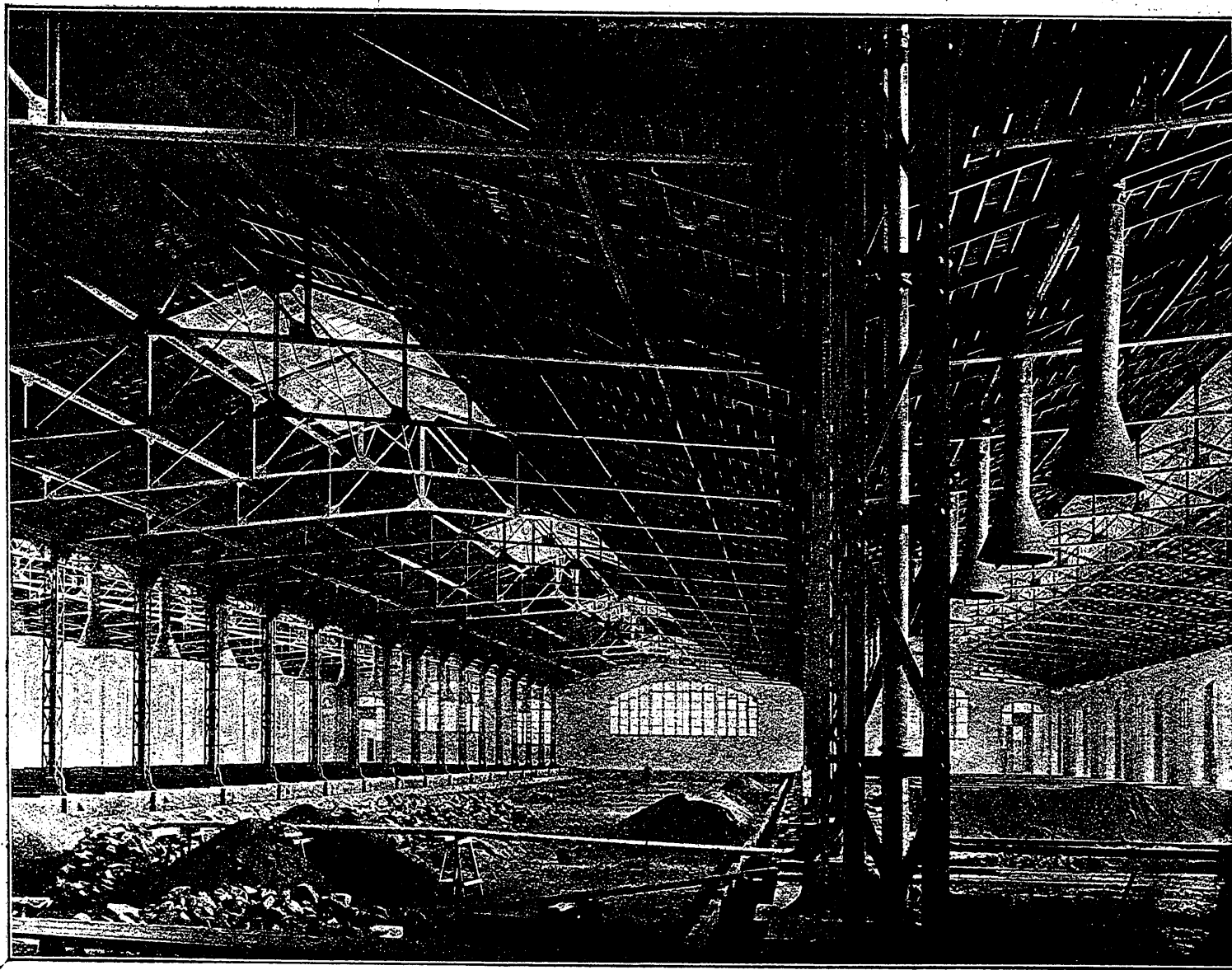
Cocherón de máquinas. — Vista interior.
