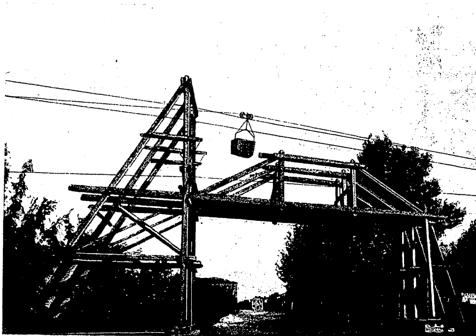
Fig. B. - Puente protector de la carretera - Azucarera Ostigliese.
