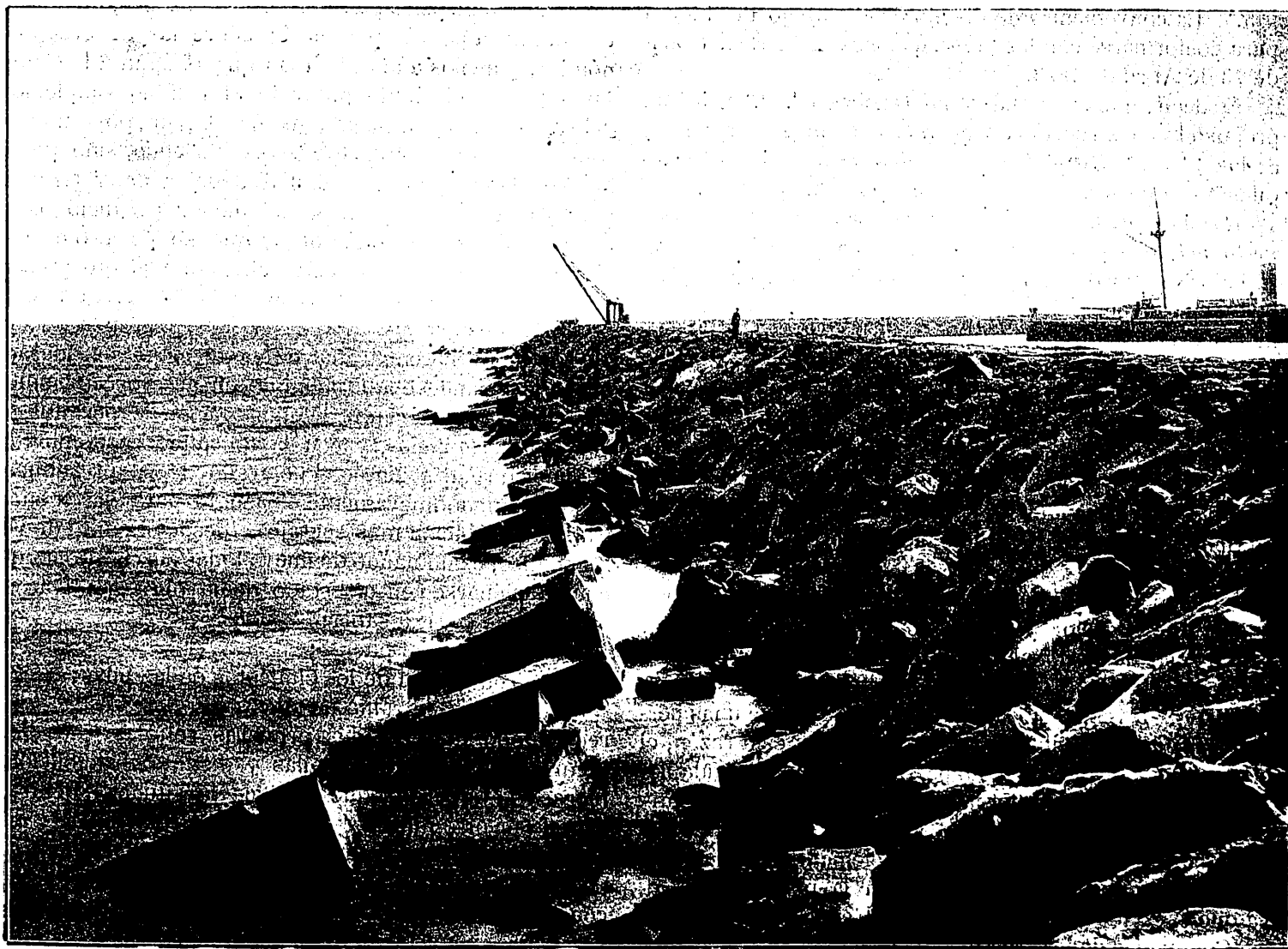
Puerto de Barcelona.—Dique del Este.—Vista exterior en el arranque.
