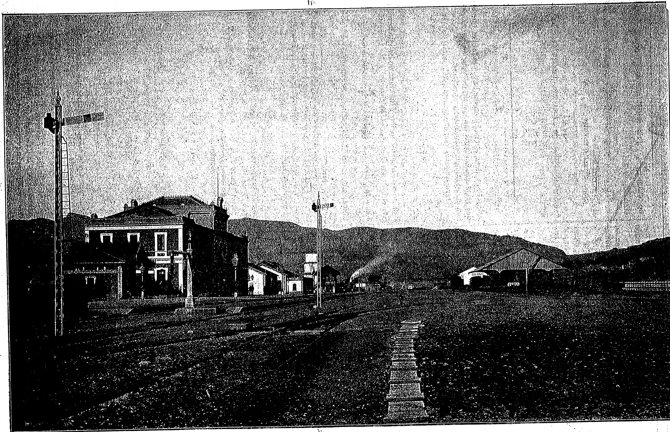
Vista general de la estación de Mora.—Ferrocarril de Zaragoza á Barcelona por Reus.
