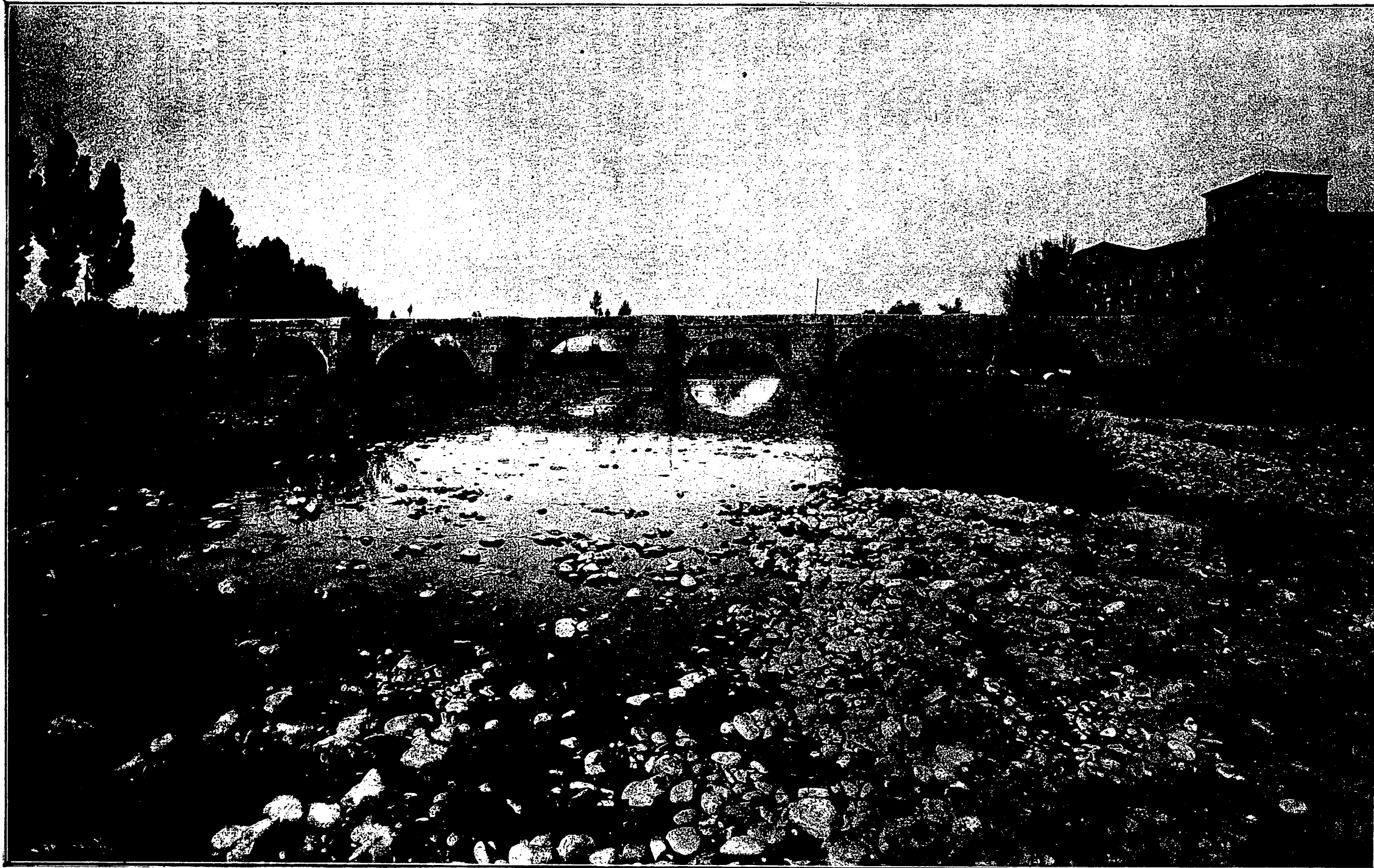
Puente sobre el Bernesga, en León.
