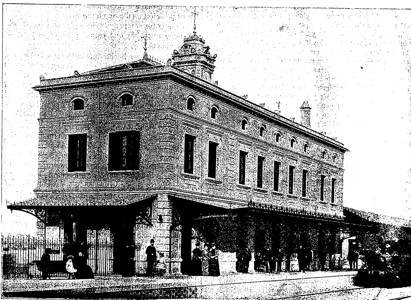
Estación de Portugalete.
