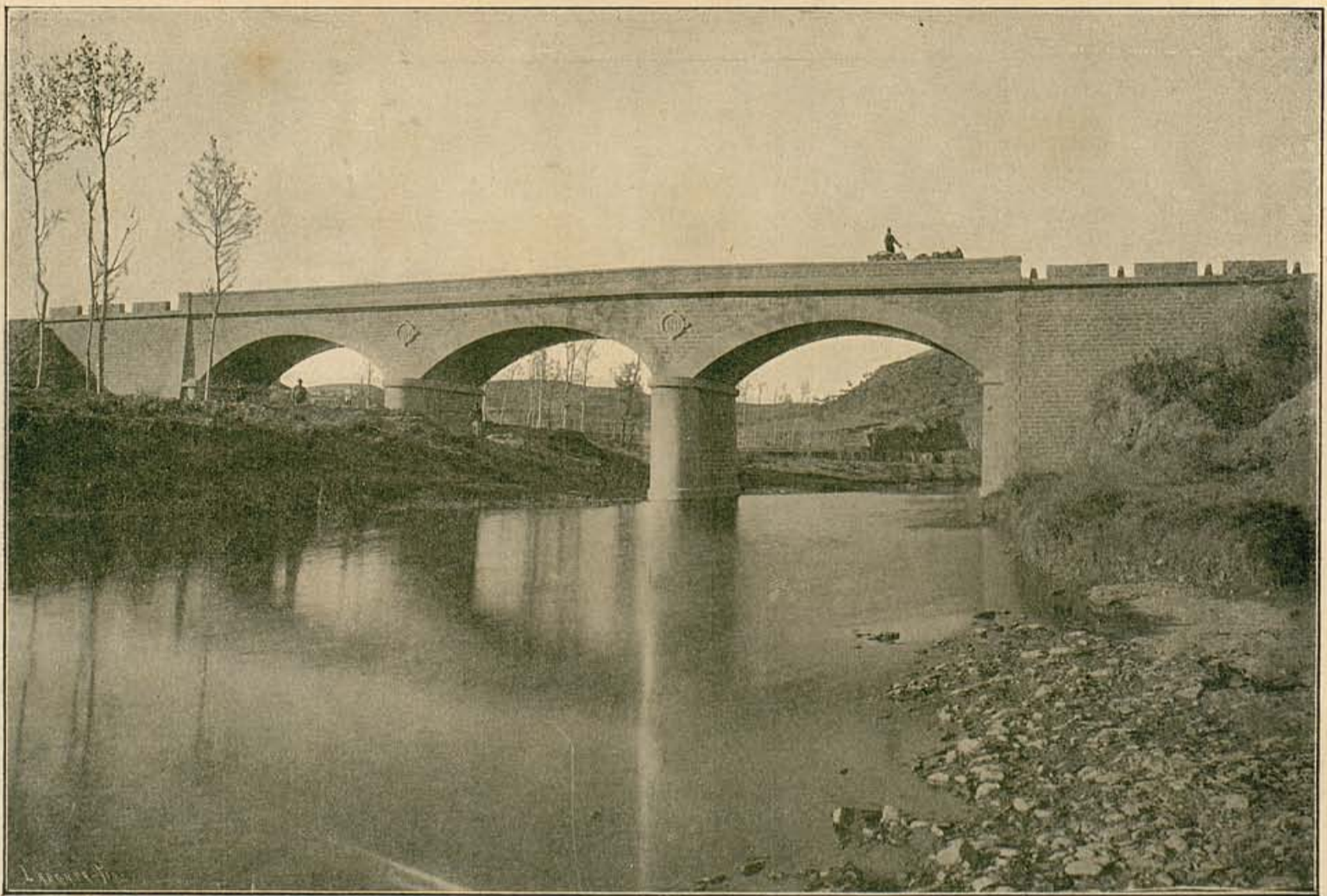
Puente sobre «La Gabarresa» (tres arcos de 12 metros de luz rebajados al \frac{1}{3} ).—Carretera provincial de Moyá á Calaf por Suria (Barcelona).
