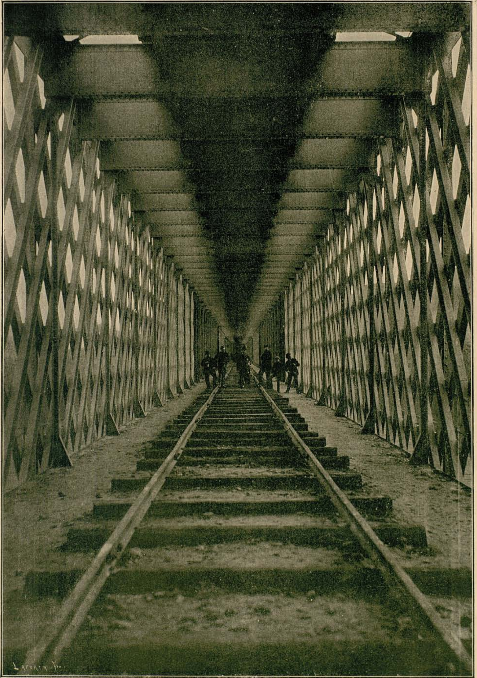
Fuente internacional sobre el Miño (Pontevedra).—Piso inferior destinado al paso de la carretera.
