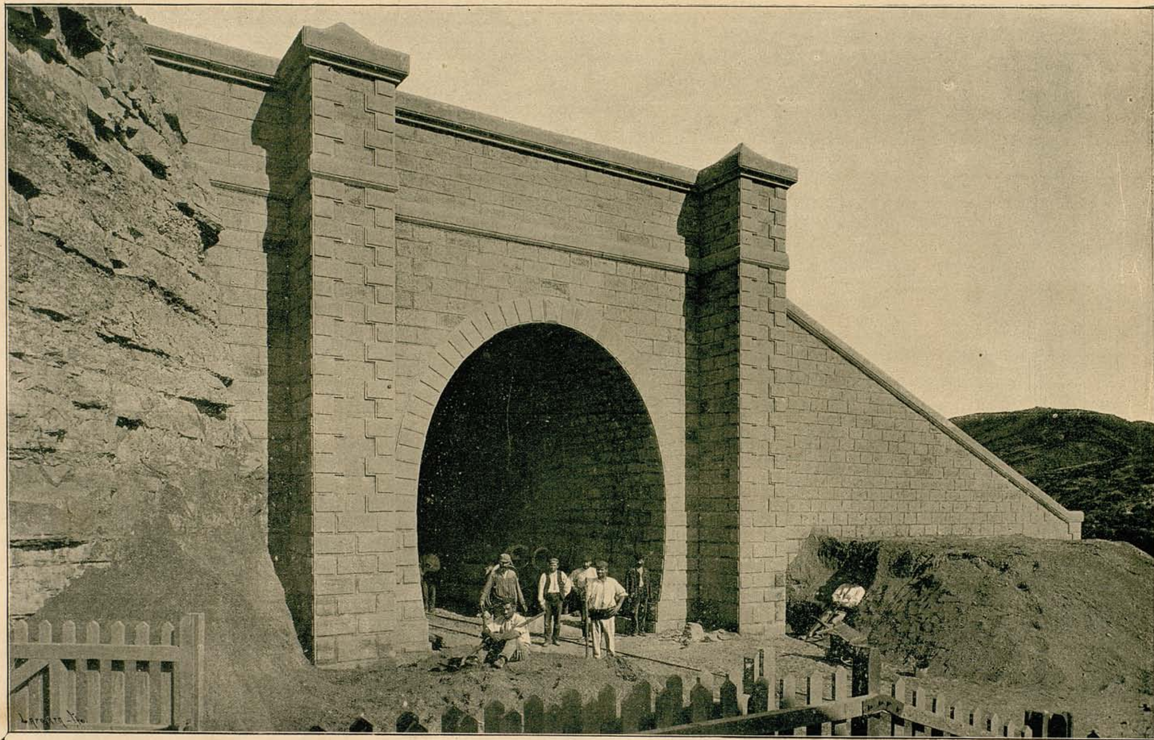
Túnel de Fayón.—Ferrocarril de Zaragoza á Barcelona.—Sección de Samper á Reus.
