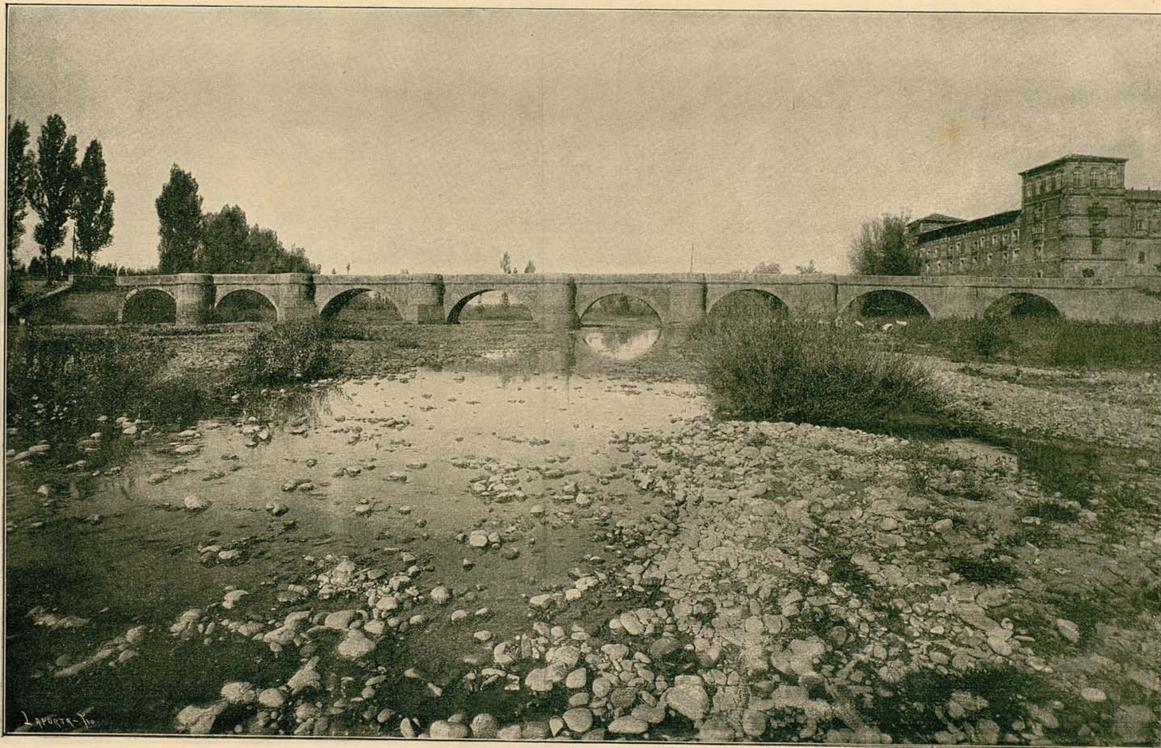
Puente sobre el Beruesga, en León.
