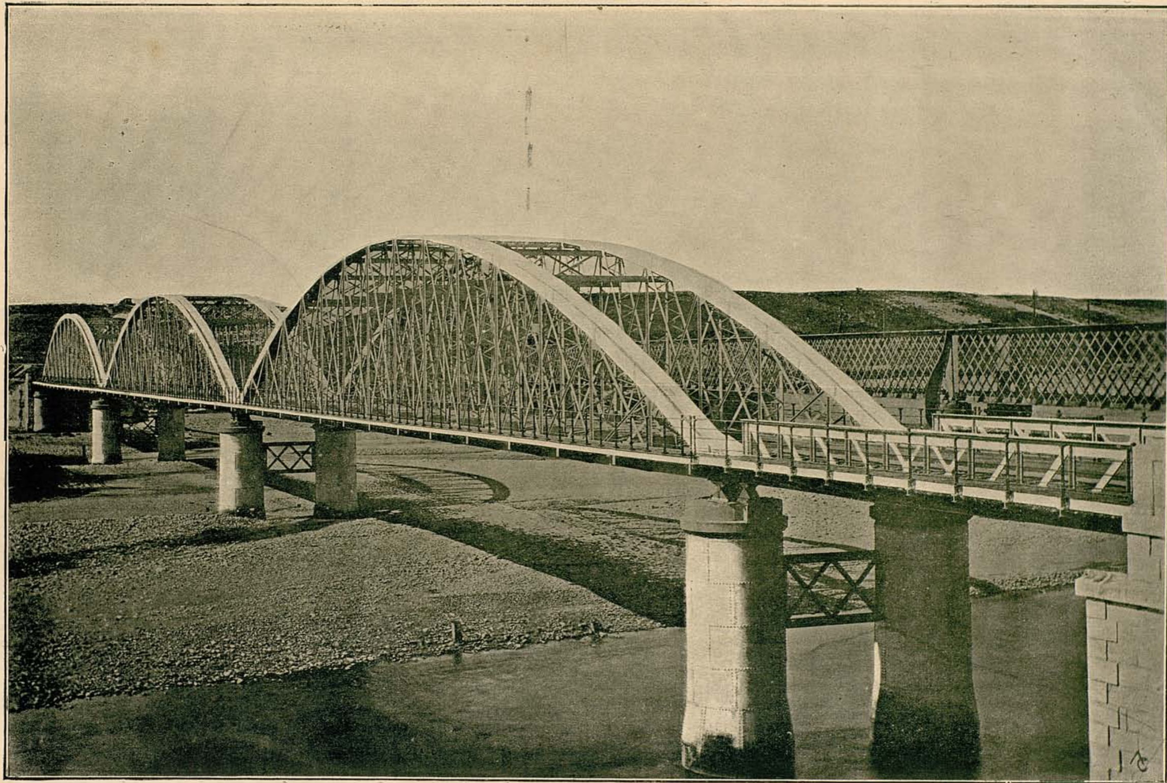
Puente sobre el río Cinca, en Monzón.
