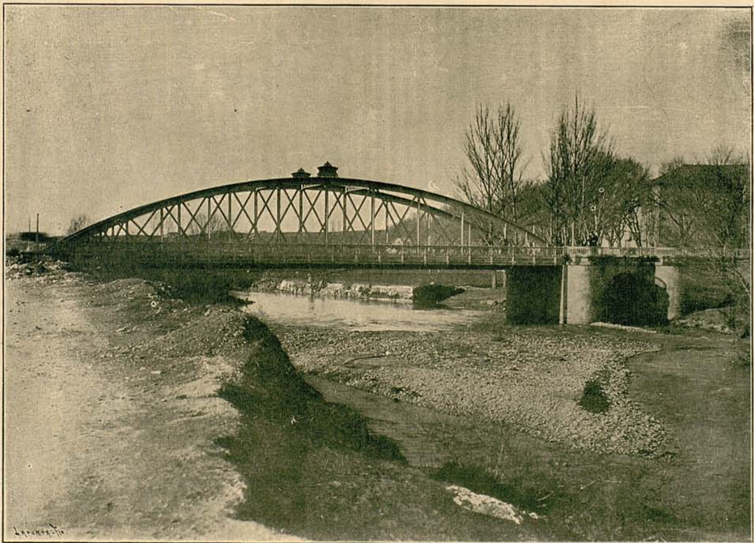
Puente de San Francisco (85 metros de luz).—Carretera de Tarancón á Teruel (Teruel)
