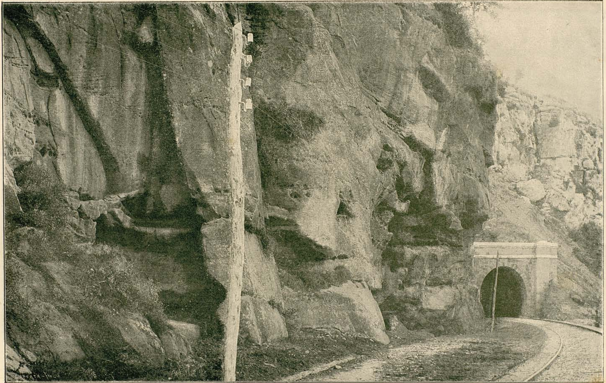
Túnel de Cova Roja.—Ferrocarril de Zaragoza á Barcelona por Reus.
