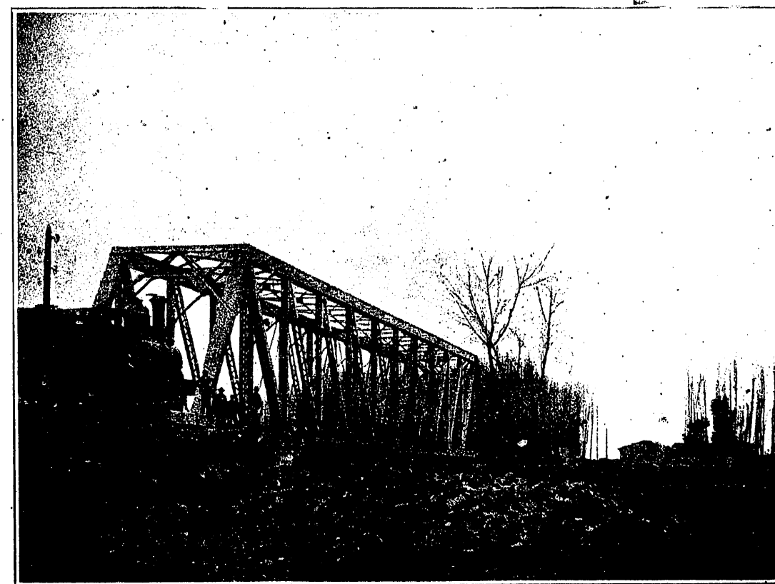
Puente sobre el río Duerna.
